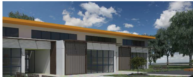
Slika 4. Prikaz pokretnih drvenih brisoleja na grupnim sobama
