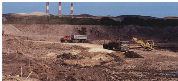
Slika 3. Izgled lokacije pre sanacije - Harborside International Golf Links, Chicago
