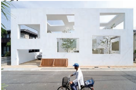
Slika 8. izgled kuće sa ulice
