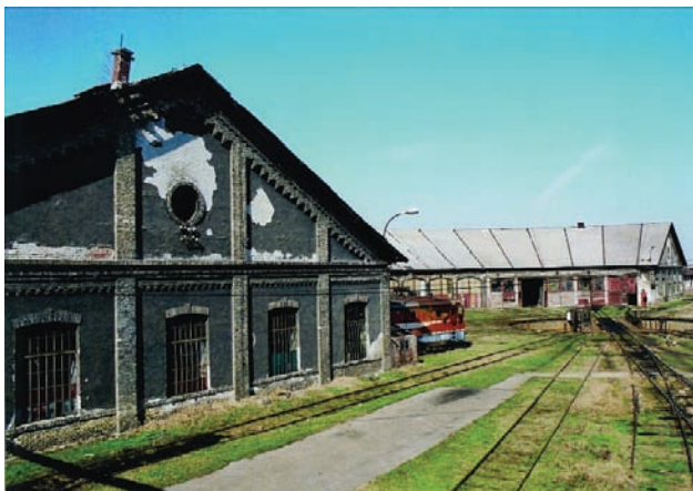
Slika 1. Ranžina stanica u Novom Sadu
