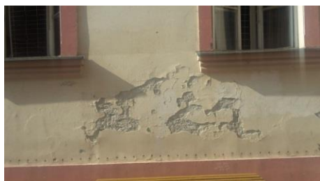
Slika 2. Ljuskanje fasade usled prisustva vlage u zidovima
