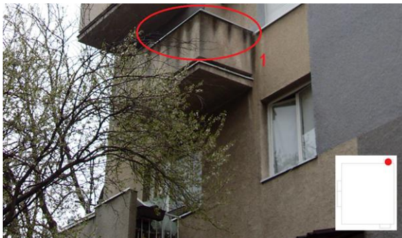
Slika 4. Vlažne mrlje usled slivanja vode
