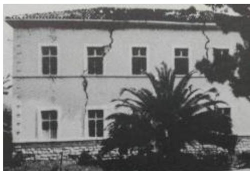
Slika 12. Oštećenja kamene zgrade, koja nije ukrućena monolitnom tavanicom, usled zemljotresa, Bečići, 1979
