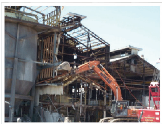
Slika 2 –Mašinsko rušenje hidrauličnim bagerom
