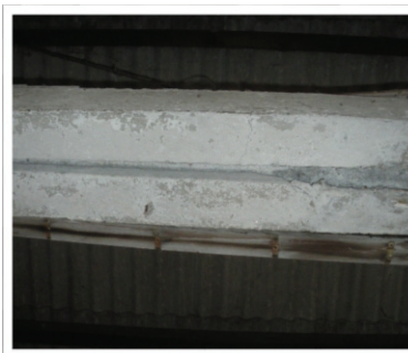
Slika 7- Ljuskanje završnog premaza
