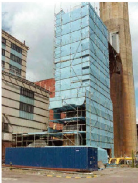
Slika 3. Ograđena struktura za uklanjanje azbestne obloge iz cevi za izlazne gasove [7]
