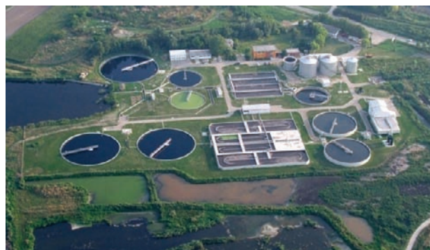
Slika 1. Novi prečištač otpadnih voda
