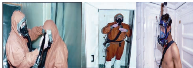
Slika 4. Dekontaminacija usisivačem tipa H, pod tušem u vodootpornom kombinezonu i finalno tuširanje pre otklanjanja opreme za zaštitu disajnih organa [9]
