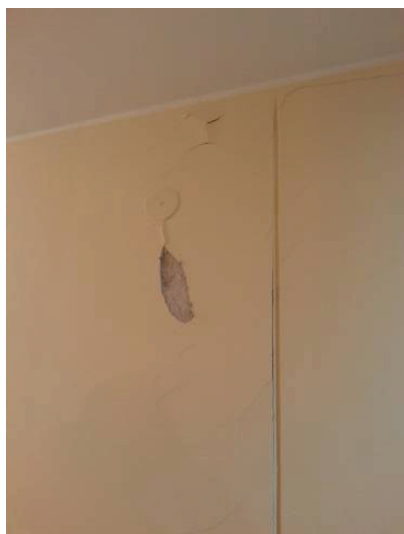
Слика 4. Одвајање малтера у ходнику
