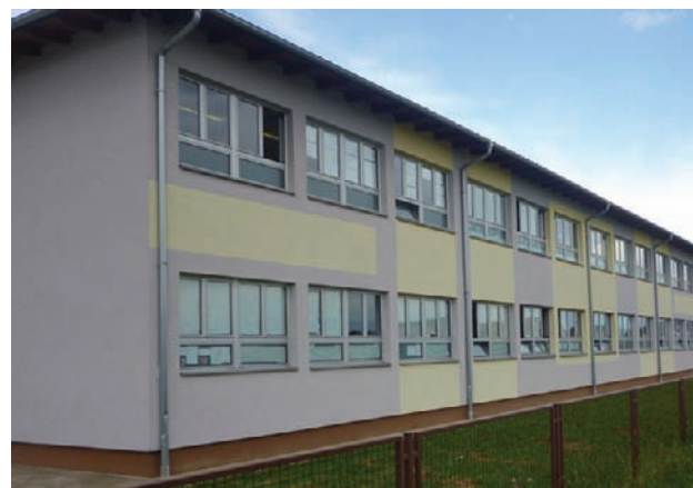
Слика 3. - Изглед школског објекта
