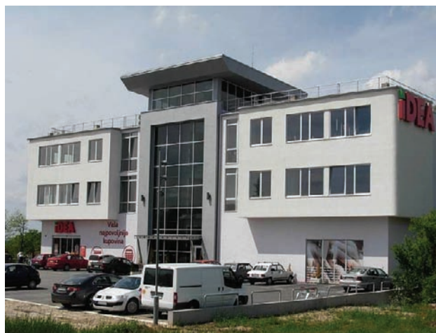
Слика 1. Изглед фасаде објекта
