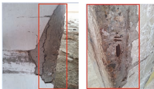
Slika 12. Ivice koje treba odštemati i očistiti armaturu
