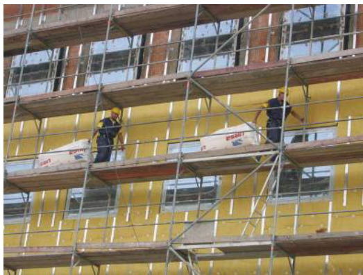
Slika 2. Postavljanje termoizolacije
