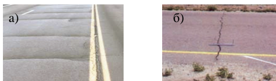
Слика 4: а) Рефлектоване пукотине; б) Попречне пукотине
