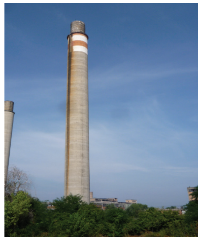
Slika 3- Izgled dimnjaka fabrike "Lozofan"
