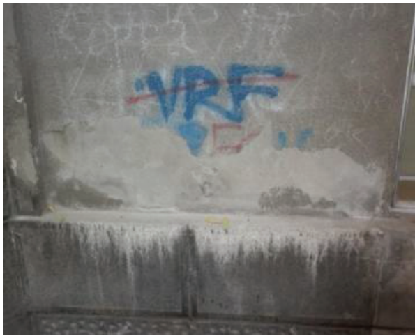
Slika 4. - Mrlje od vlage, trošan malter
