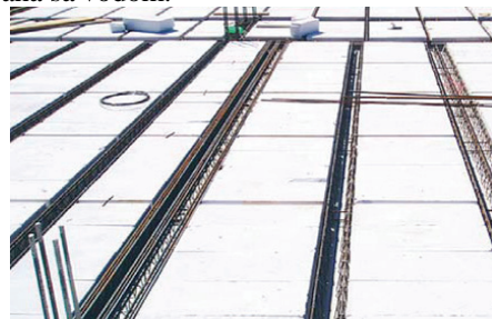
Slika 6: Pripremljena tavanica za betoniranje
