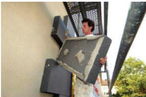
Slika 14. - Lepljenje stiropora na zid
