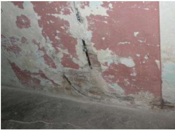
Slika 3. - Mrlje od vlage, trošan malter
