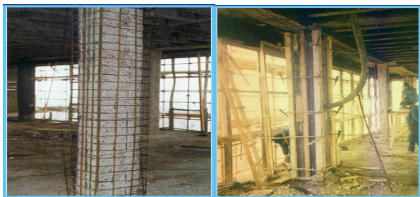
Слика 9. – Извођење АБ „плашта” код ојачања стуба
