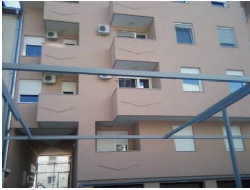
Слика 4. - Изглед завршне фасаде постојећег објекта
