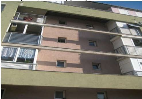
Слика 5. - Изглед завршне фасаде постојећег објекта
