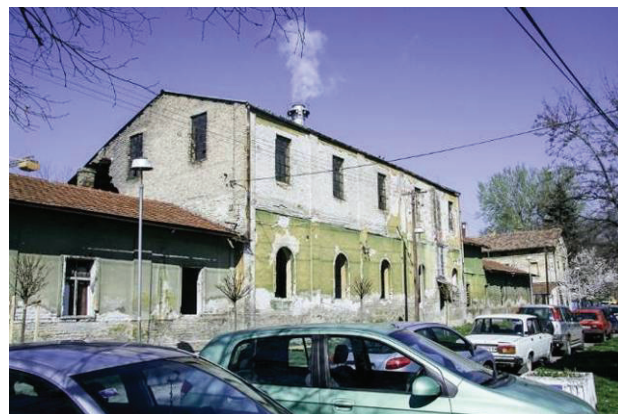
Slika 2. Napušteni objekat u Šumadijskoj ulici
