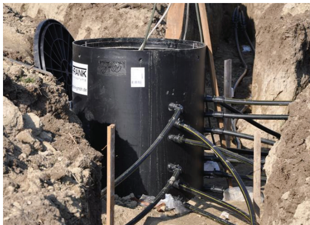
Slika 2. Instalacija geotermalne sonde
