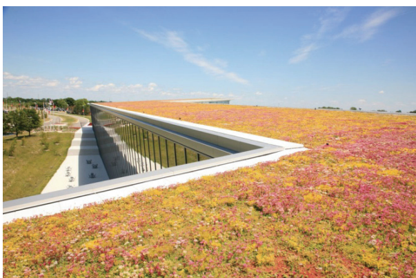
Slika 2.1 Ekstenzivni zeleni krov na poslovnoj zgradi
