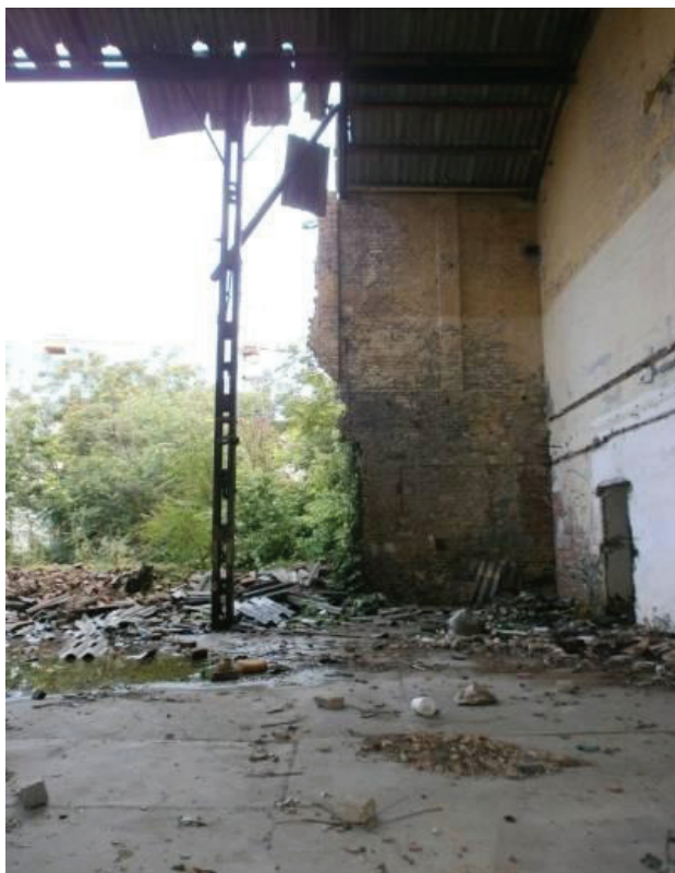
Slika 3. Fotografija postojećeg stanja objekta
