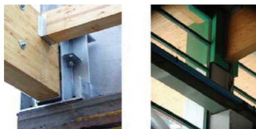
Слика 8. а) Незаштићене везе б) Везе заштићене опшивањем плочама равног етернита [3]
