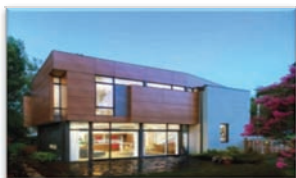
Slika 12. Renovirana ekološka kuća u gradu Arlington, SAD
