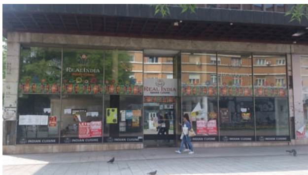
Slika 1. Postojeće stanje lokala
