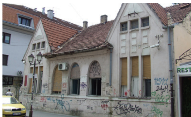
Slika 1. Postojeće stanje objekta
