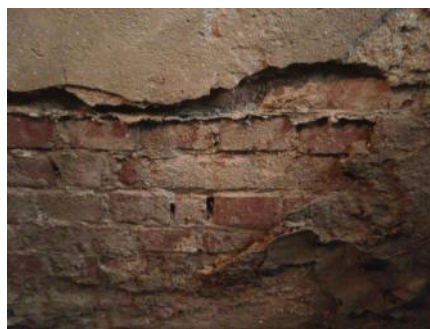
Слика 6. – Трошан малтер и малтерске спојнице
