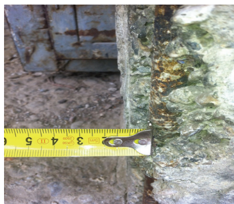
Slika 4: Nedovoljna debljina zaštitnog sloja
