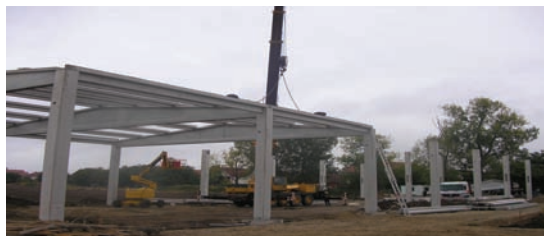
Slika 3. TIP 3 - konstrukcija od AB stubova i rigli od AB
