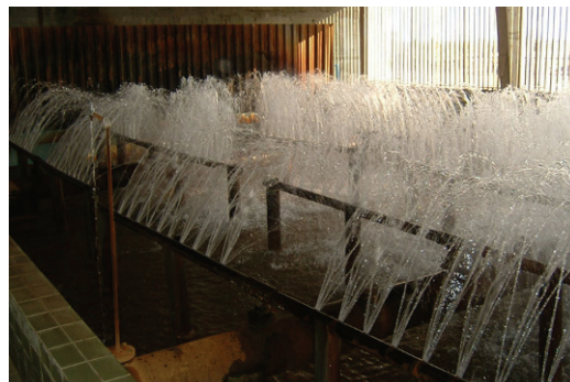
Slika 1. Aeracija raspršivanjem
