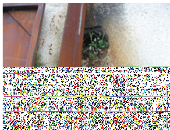
Slika 8: Korozija oluka
