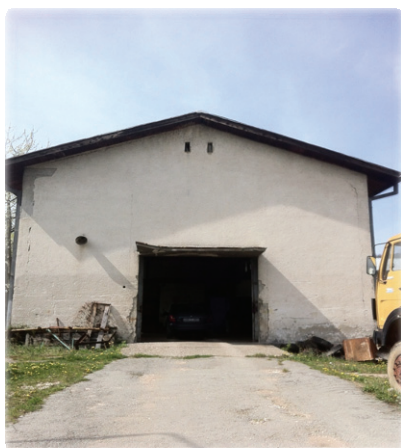
Slika 1: Izgled istočne fasade
