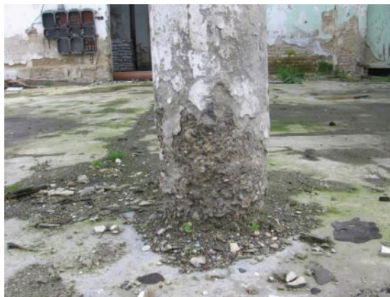
Slika 13. Vidljivo zrno agregata, ispran cem. kamen
