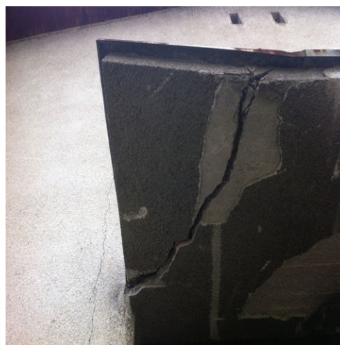
Slika 7: Mehaničko oštećenje konzolne ploče
